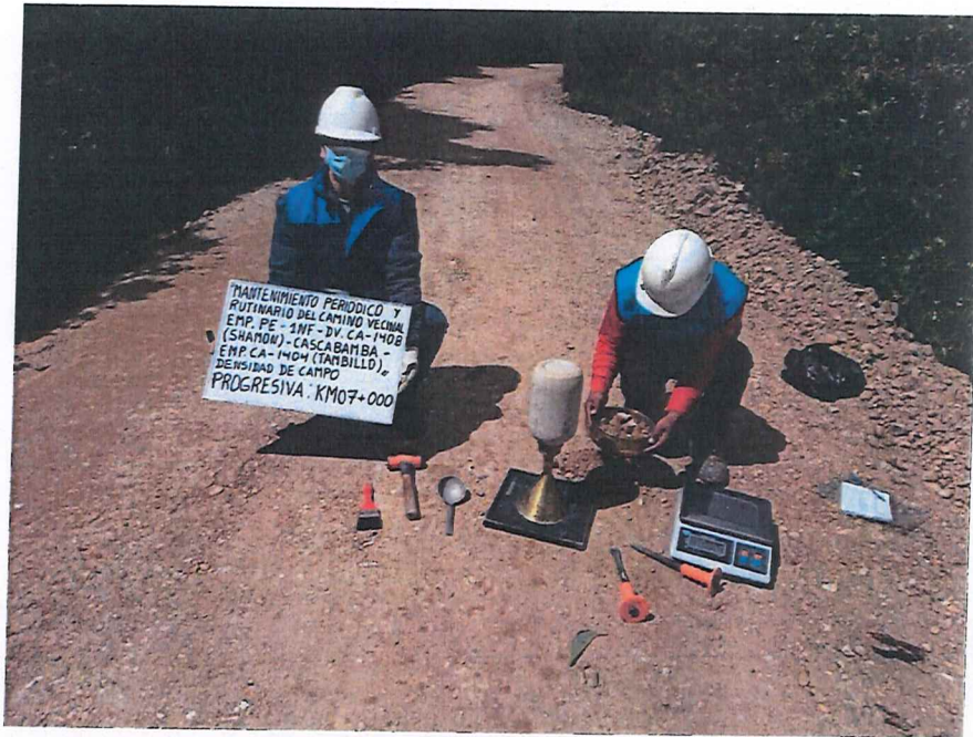
FIGURA N° 29. Ensayo de Densidad de Suelo en Campo. Progresiva 07 + 000 (Método del cono de arena).
