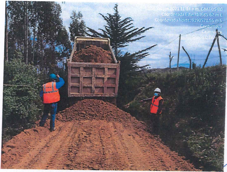
Fotografía 23. Descarga del material para el afirmado.
