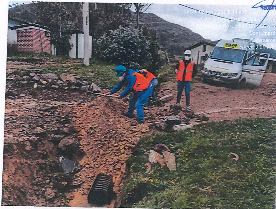
Fotografía 16. Mejoramiento de alcantarilla en el km 10 (Cascabamba).
