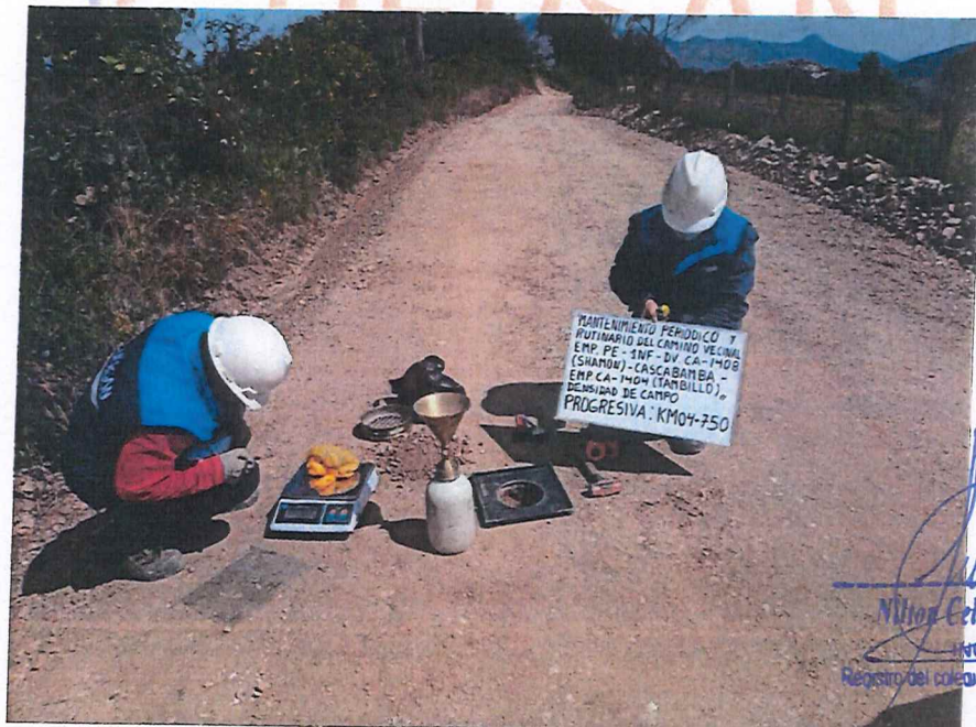
FIGURA N° 20. Ensayo de Densidad de Suelo en Campo. Progresiva 04 + 750 (Método del cono de arena).
