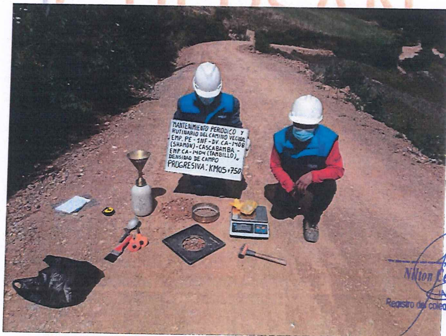
FIGURA N° 24. Ensayo de Densidad de Suelo en Campo. Progresiva 05 + 750 (Método del cono de arena).
