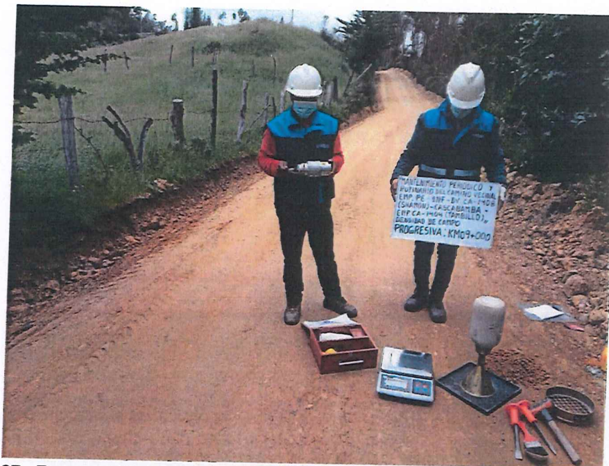
FIGURA N° 37. Ensayo de Densidad de Suelo en Campo. Progresiva 09 + 000 (Método del cono de arena).
