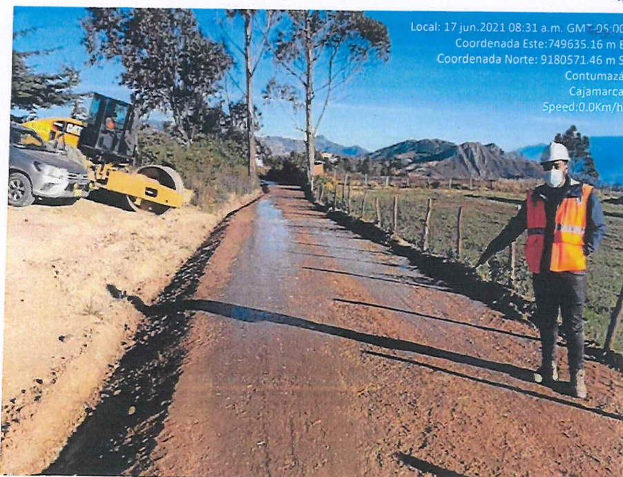
Fotografía 40. Riego de material de afirmado
