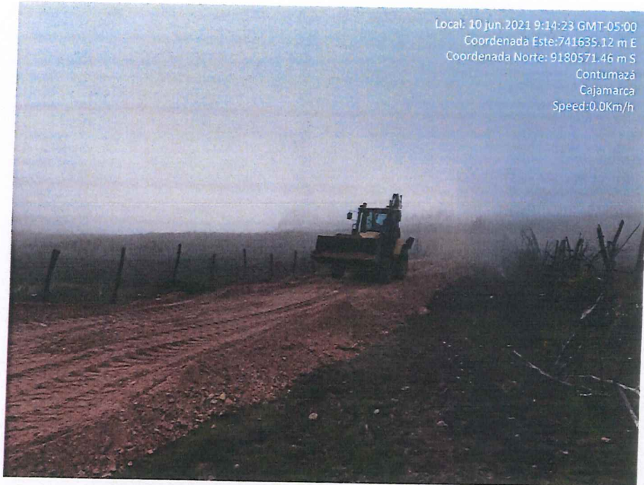
Fotografía 31. Extendido del material para afirmado.
