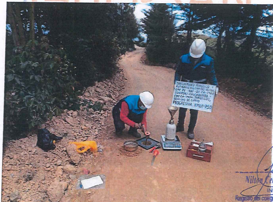
FIGURA N° 36. Ensayo de Densidad de Suelo en Campo. Progresiva 08 + 750 (Método del cono de arena).
