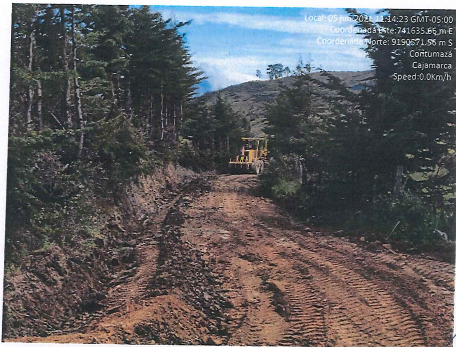
Fotografía 19. Trabajos de mejoramiento de la subrasante.
