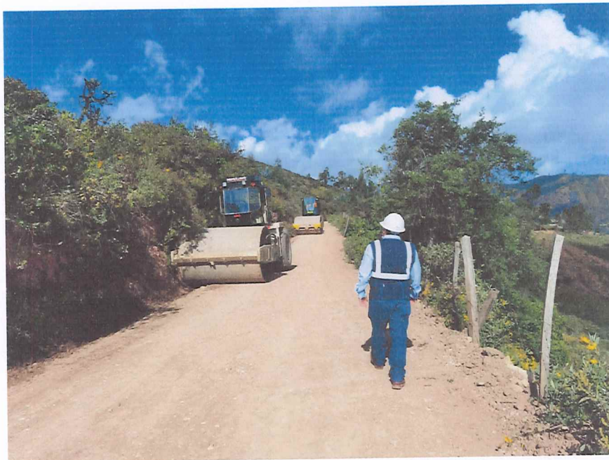
SE OBSERVA AL INSPECTOR DEL SERVICIO, REALIZANDO LA VERIFICACION DE LA COMPACTACIÓN DEL MANTENIMIENTO EN EL TRAMO KM 12 + 950 .
