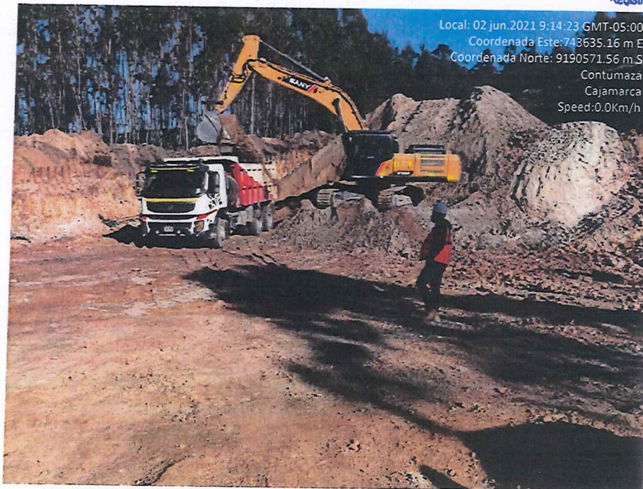
Fotografía 12. Carguío del material de cantera para el afirmado.
