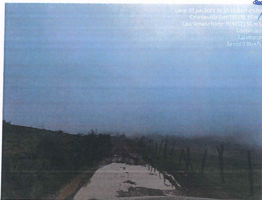
Fotografía 6. Estado del tramo antes de la suspensión de la Fase II.
