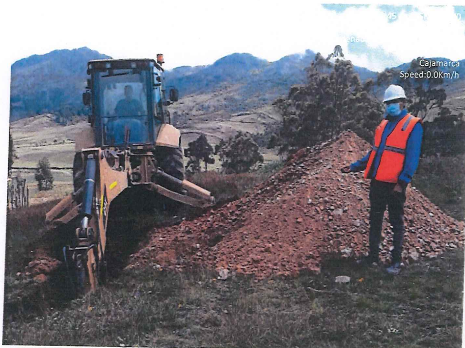
Fotografía 27. Calicata en la cantera para extraer material para capa nivelante e= 0.05m.
