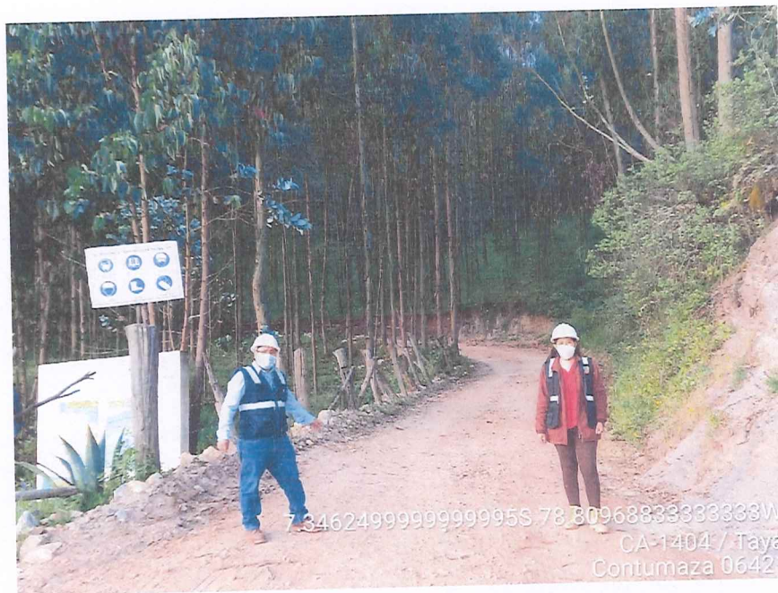
SE OBSERVA LA VERIFICACIÓN CON LA ANALISTA DE LA MUNICIPALIDAD EN EL INICIO DEL TRAMO EN MANTENIMIENTO UBICADA EN EL HITO KILOMETRICO 0+00 KMS..
