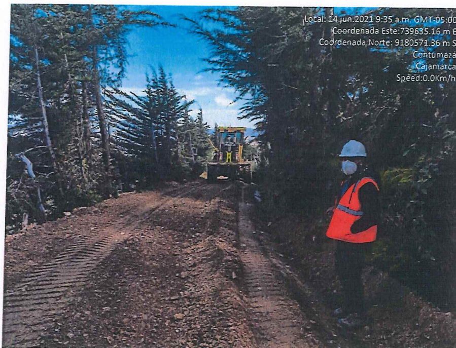
Fotografía 33. Conformación y reconformación de cunetas.
