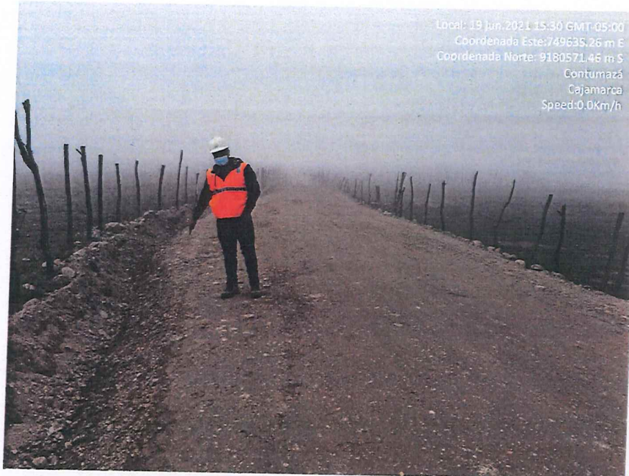
Fotografía 55. Resultado de la compactación del afirmado y reconformación de cunetas
