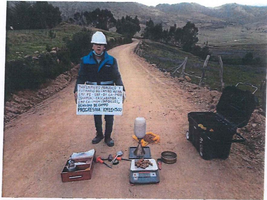
FIGURA N° 47. Ensayo de Densidad de Suelo en Campo. Progresiva 11 + 500 (Método del cono de arena).
