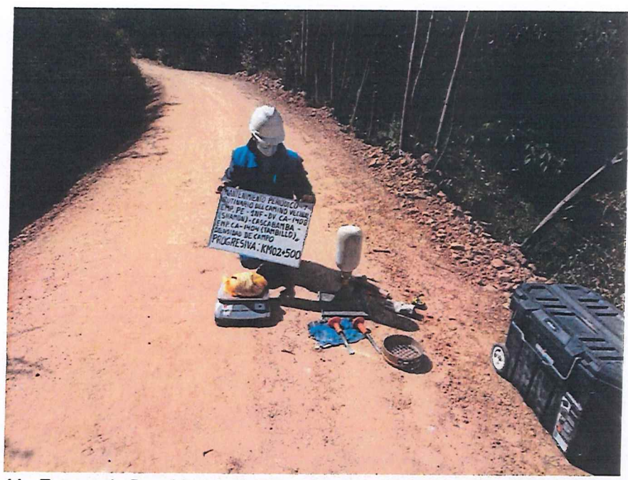
FIGURA N° 11. Ensayo de Densidad de Suelo en Campo. Progresiva 02 + 500 (Método del cono de arena).
