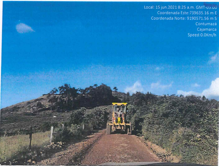
Fotografía 36. Conformación y reconformación de cunetas.
