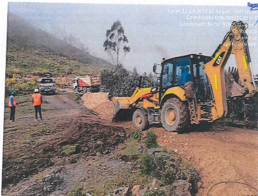
Fotografía 32. Culminación del extendido del material granular para afirmado e=0.15m
