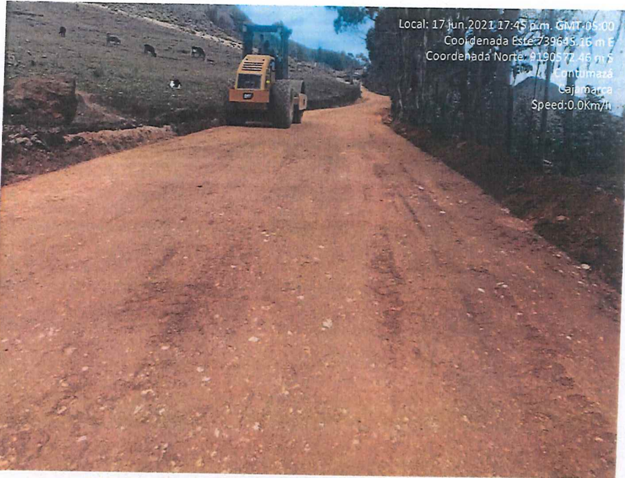
Fotografía 43. Refine y compactación de material granular para afirmado e=0.15m
