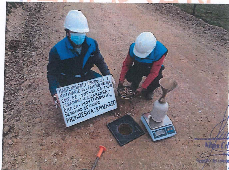
FIGURA N° 42. Ensayo de Densidad de Suelo en Campo. Progresiva 10 + 250 (Método del cono de arena).
