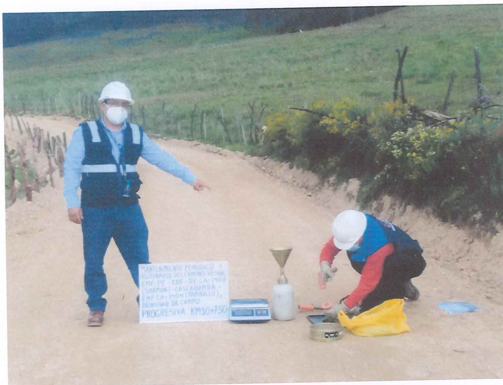
SE OBSERVA AL INSPECTOR DEL SERVICIO VERIFICANDO LA OBTENCION DE MUESTRAS PARA REALIZAR LA DENSIDAD DE CAMPO, SEGÚN LO INDICADO EN EL PLAN DE TRABAJO.
