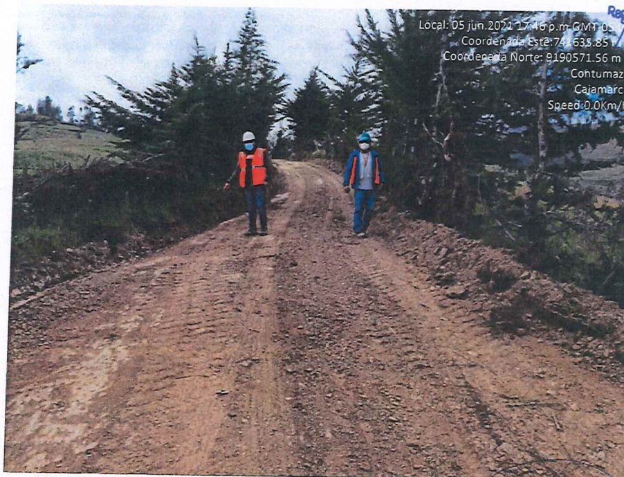
Fotografía 20. Resultado del trabajo del mejoramiento de la subrasante.
