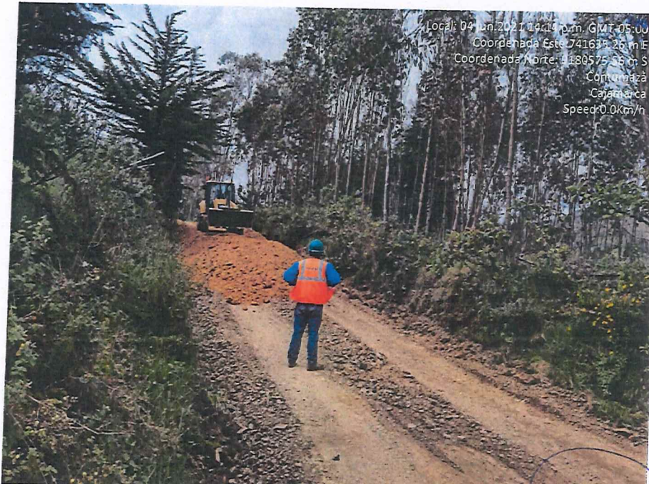
Fotografía 29. Mejoramiento de la capa nivelante con material grueso para mejorar drenaje
