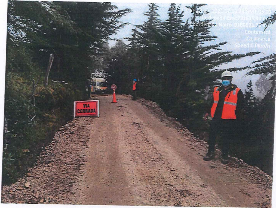
Fotografía 45. Señalización de seguridad en campo.
