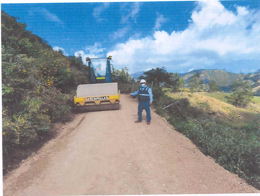
SE OBSERVA AL INSPECTOR DEL SERVICIO REALIZANDO LA VERIFICACION DE LA COMPACTACIÓN EN EL TRAMO KM. 08+390 DEL MANTENIMIENTO DE LA CARRETERA.
