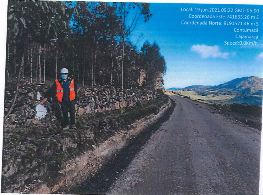
Fotografía 47. Resultado de la compactación del afirmado en la última progresiva.
