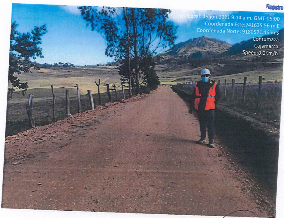
Fotografía 54. Resultado de la compactación del afirmado.
