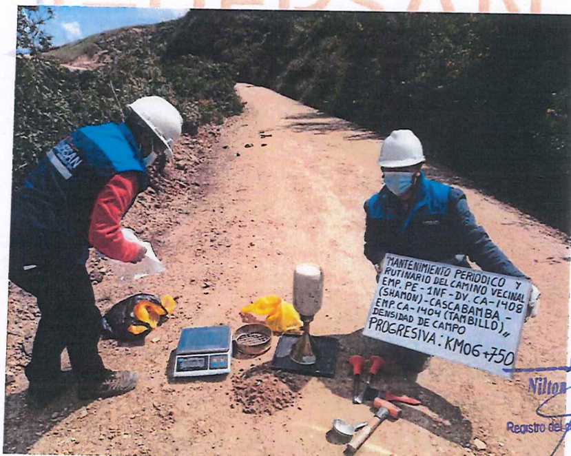
FIGURA N° 28. Ensayo de Densidad de Suelo en Campo. Progresiva 06 + 750 (Método del cono de arena).
