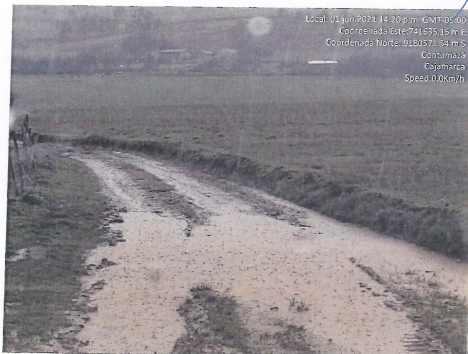
Fotografía 4. Estado del tramo antes de la suspensión de la Fase II.
