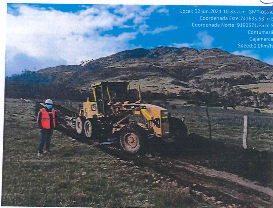
Fotografía 18. Trabajos de mejoramiento de la subrasante.
