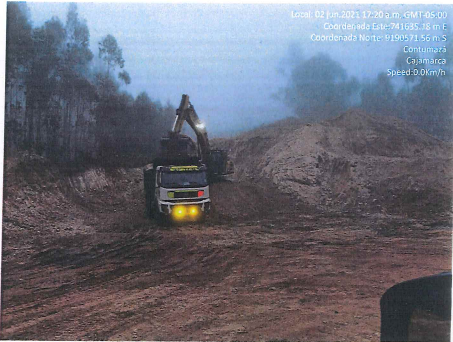
Fotografía 13. Carguío del material de cantera para el afirmado.
