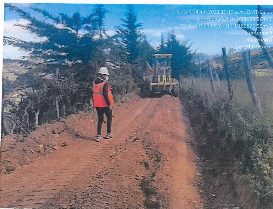
Fotografía 34. Conformación y reconformación de cunetas.
