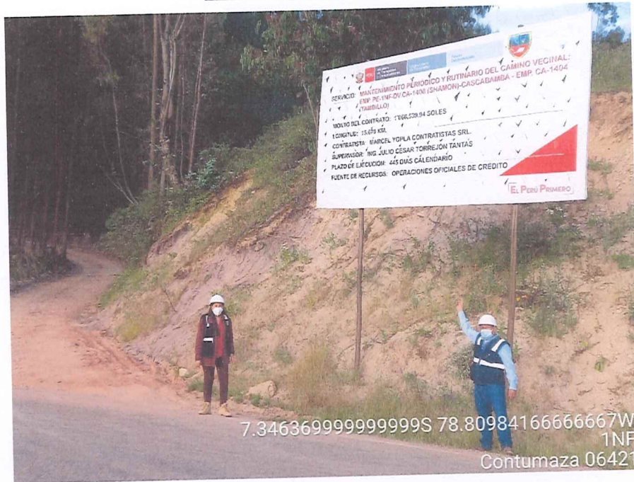
SE OBSERVA LA VERIFICACIÓN CON LA ANALISTA DE LA MUNICIPALIDAD DEL INICIO DEL TRAMO EN MANTENIMIENTO Y CARTEL DEL SERVICIO EN EL KM 0+00.
