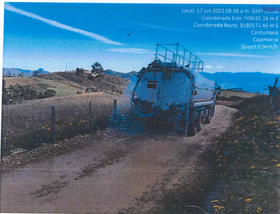
Fotografía 38. Riego de material de afirmado.
