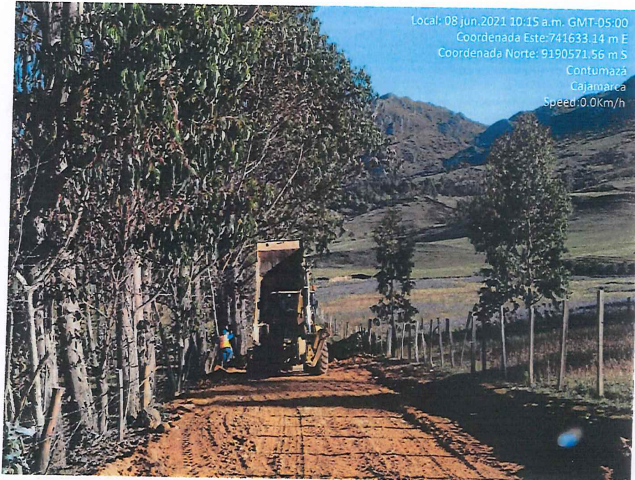
Fotografía 25. Descarga y extendido del material para el afirmado.
