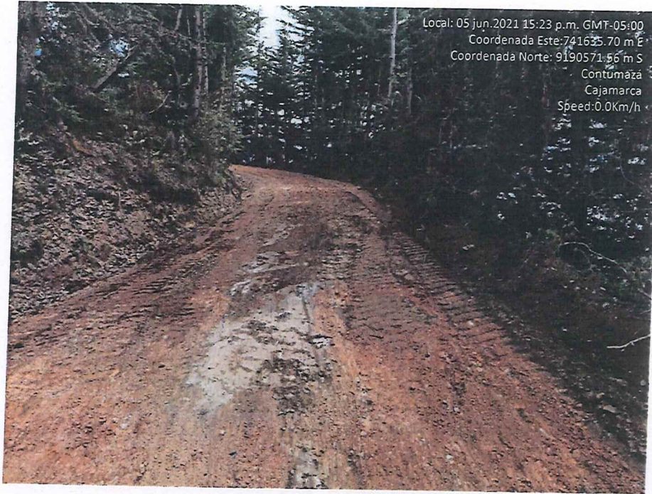
Fotografía 21. Resultado del trabajo del mejoramiento de la subrasante.
