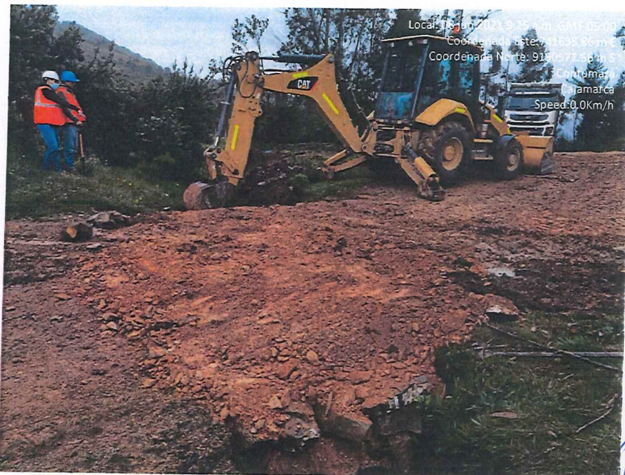
Fotografía 17. Resultado del mejoramiento de alcantarilla en el km 10 (cascabamba).
