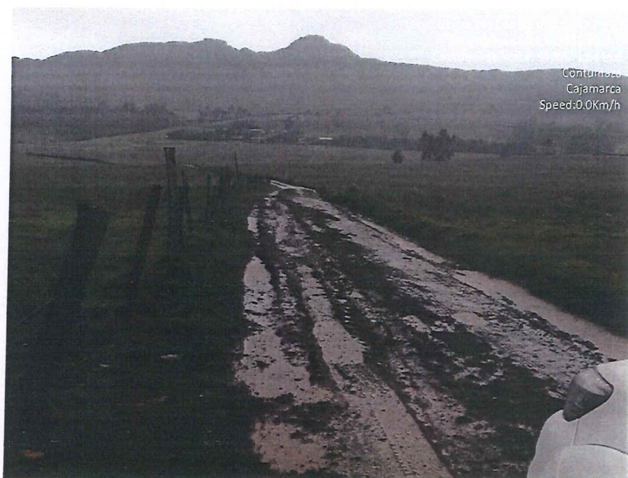
Fotografía 5. Estado del tramo antes de la suspensión de la Fase II.
