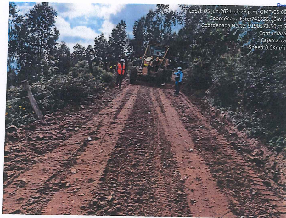
Fotografía 22. Resultado del trabajo del mejoramiento de la subrasante. MARCEL YOPLA CONTRATISTAS S.R.L.
