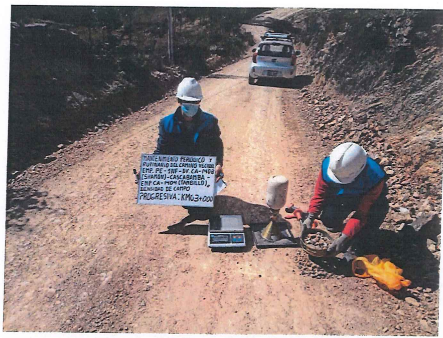
FIGURA N° 13. Ensayo de Densidad de Suelo en Campo. Progresiva 03 + 000 (Método del cono de arena).
