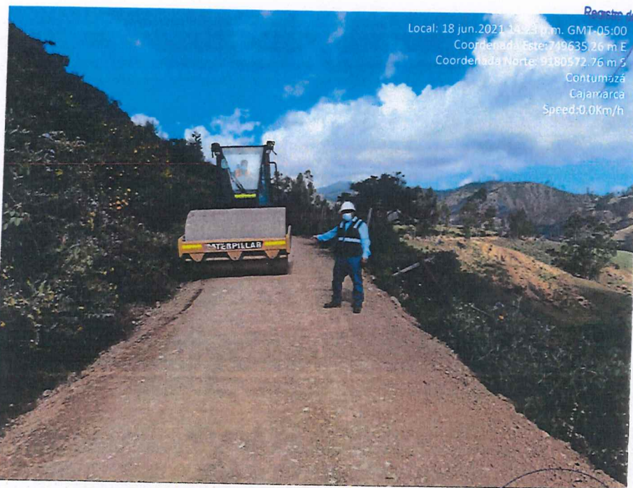
Fotografía 44. Refine y compactación de material granular para afirmado e=0.15m
