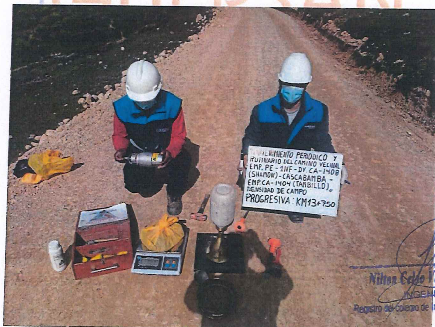
FIGURA N° 56. Ensayo de Densidad de Suelo en Campo. Progresiva 13 + 750 (Método del cono de arena).
