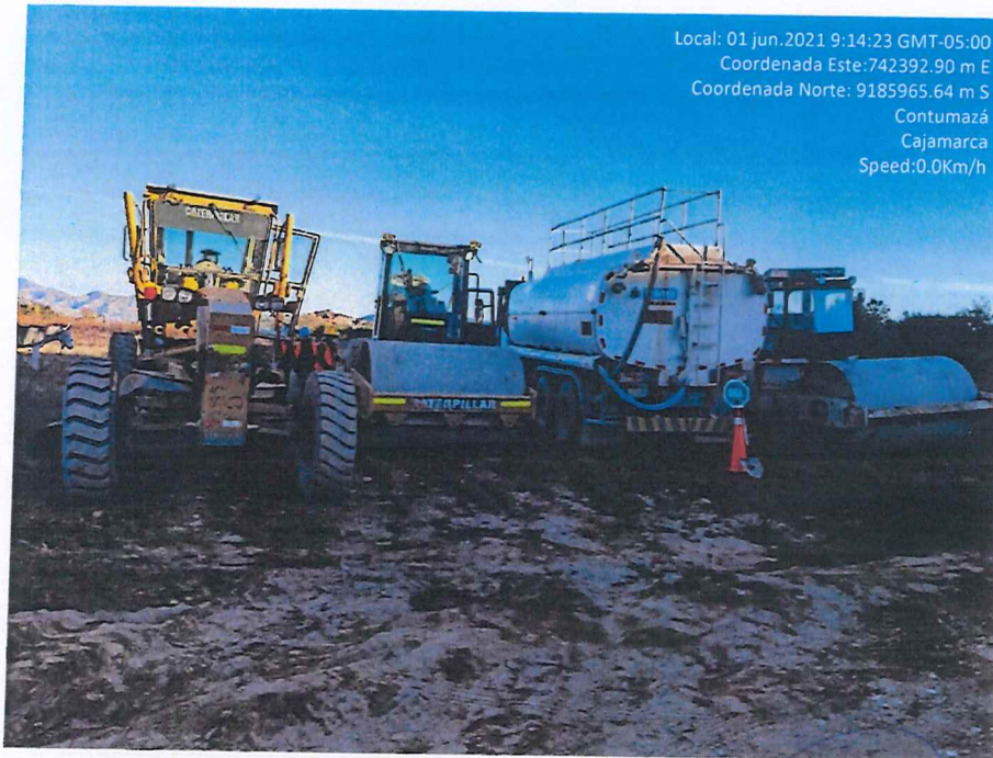
Fotografía 2. Equipamiento mínimo en el tramo.
