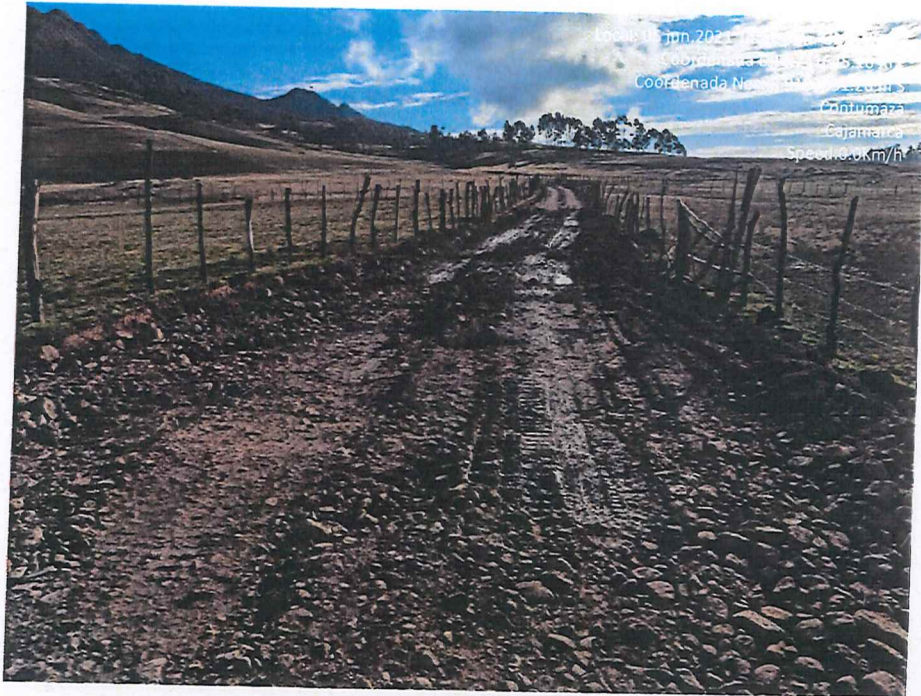
Fotografía 29. Mejoramiento de la capa nivelante con material grueso para mejorar drenaje
