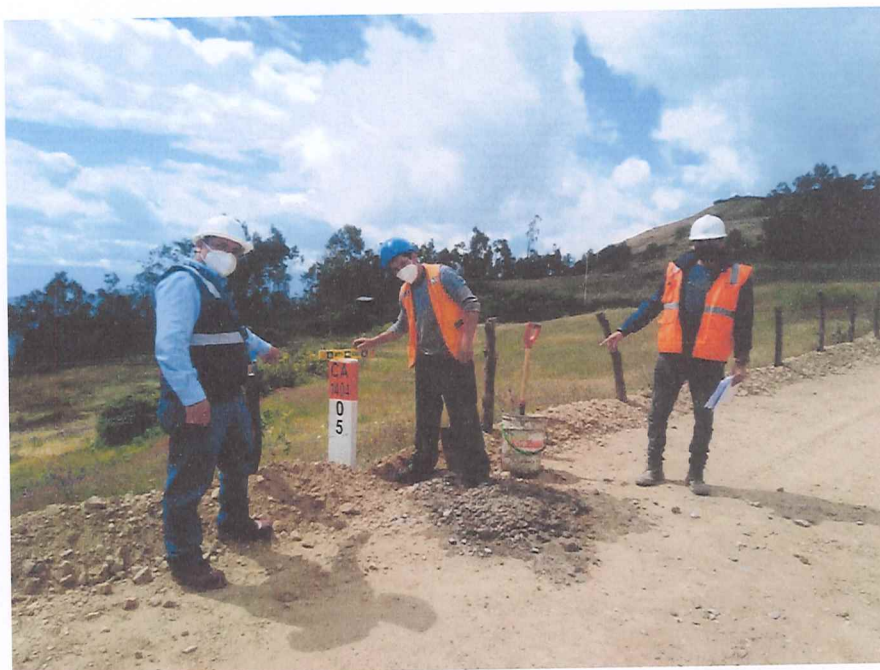
SE OBSERVA AL INSPECTOR DEL SERVICIO, REALIZANDO LA VERIFICACION DE LA FIJACIÓN DEL HITO KILOMETRICO 05 DEL MANTENIMIENTO DE LA CARRETERA.
