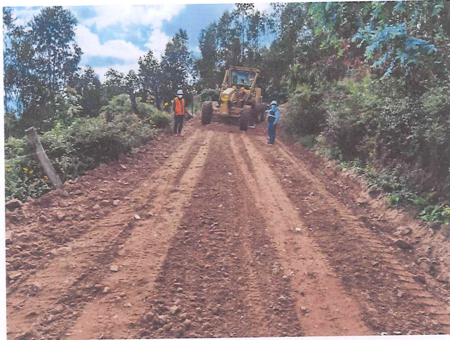
SE OBSERVA AL INSPECTOR DEL SERVICIO, CON EL RESIDENTE REALIZANDO LA VERIFICACION DE LA NIVELACION DE CAPA DE AFIRMADO CON MOTONIVELADORA.
