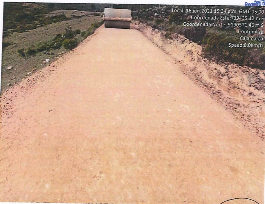
Fotografía 42. Refine y compactación de material granular para afirmado e=0.15m
