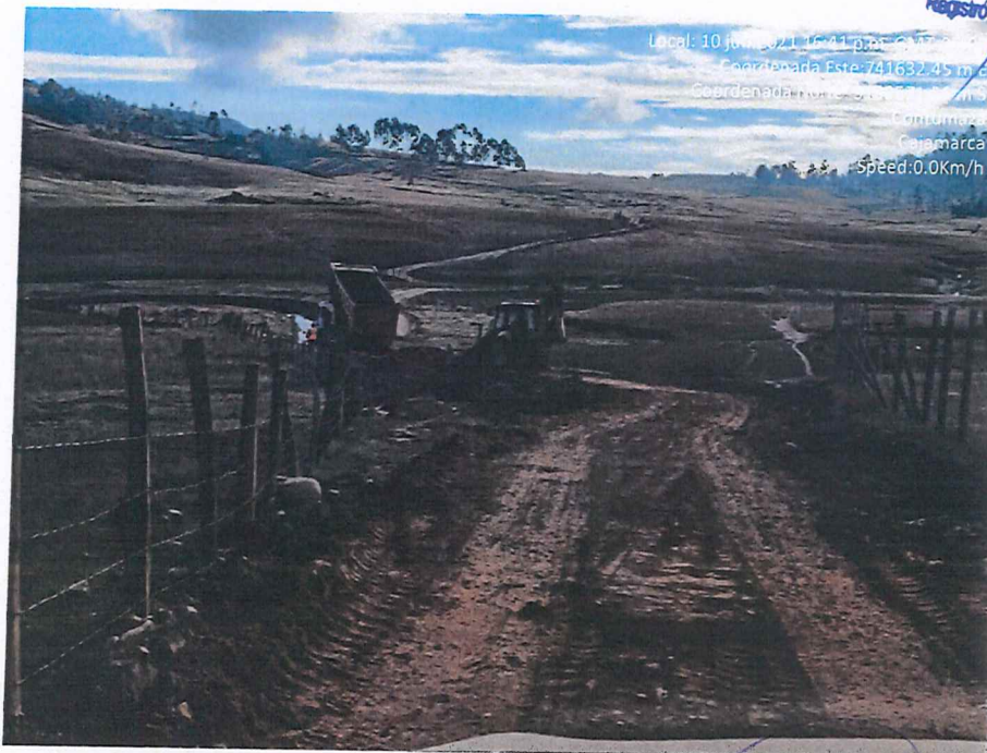
Fotografía 26. Descarga y extendido del material para el afirmado.
