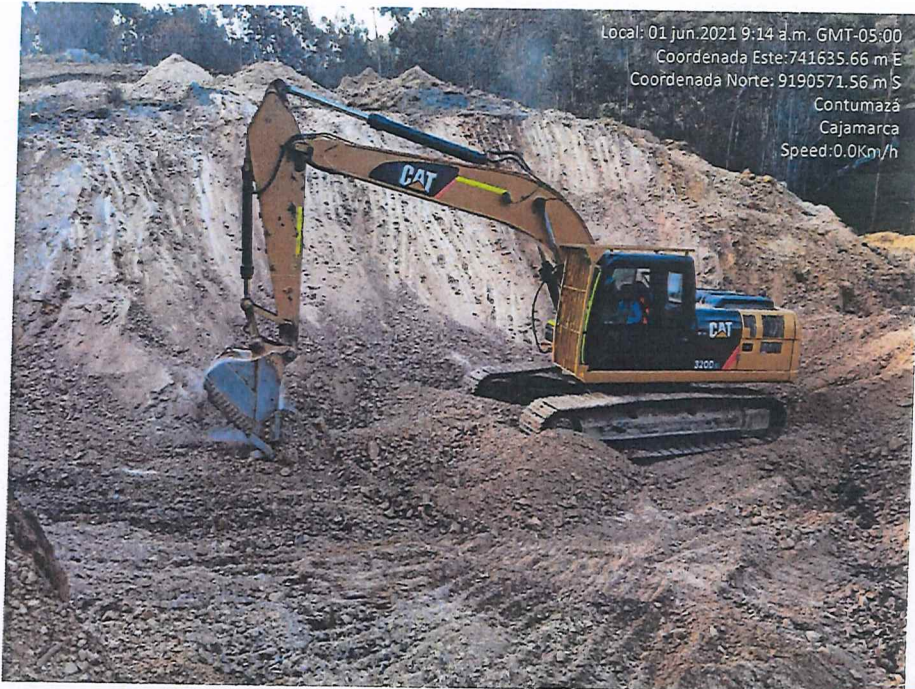
Fotografía 11. Extracción y preparación de material de cantera para el afirmado.
