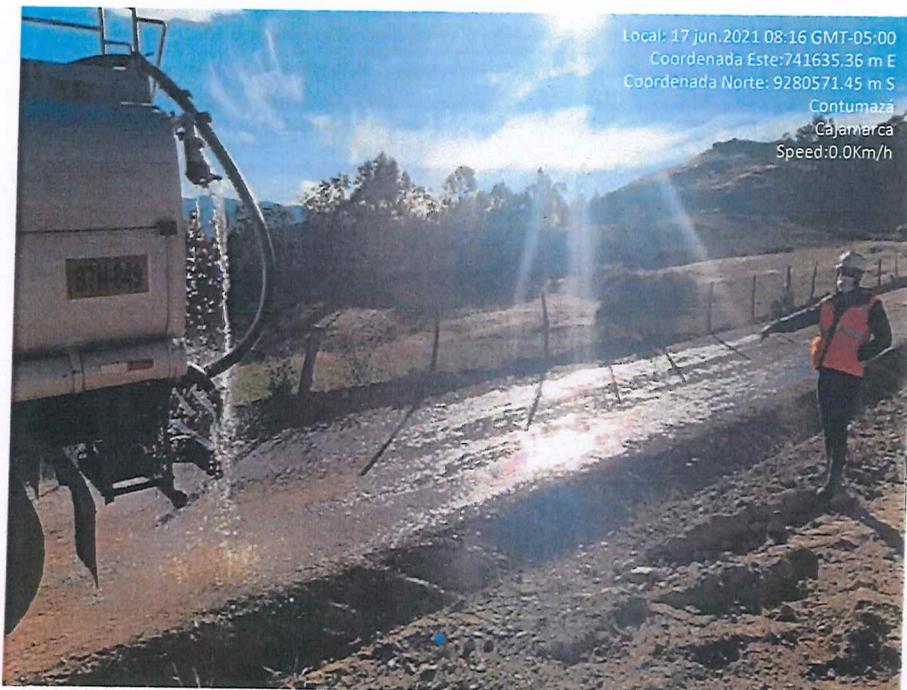
Fotografía 39. Riego de material de afirmado.
