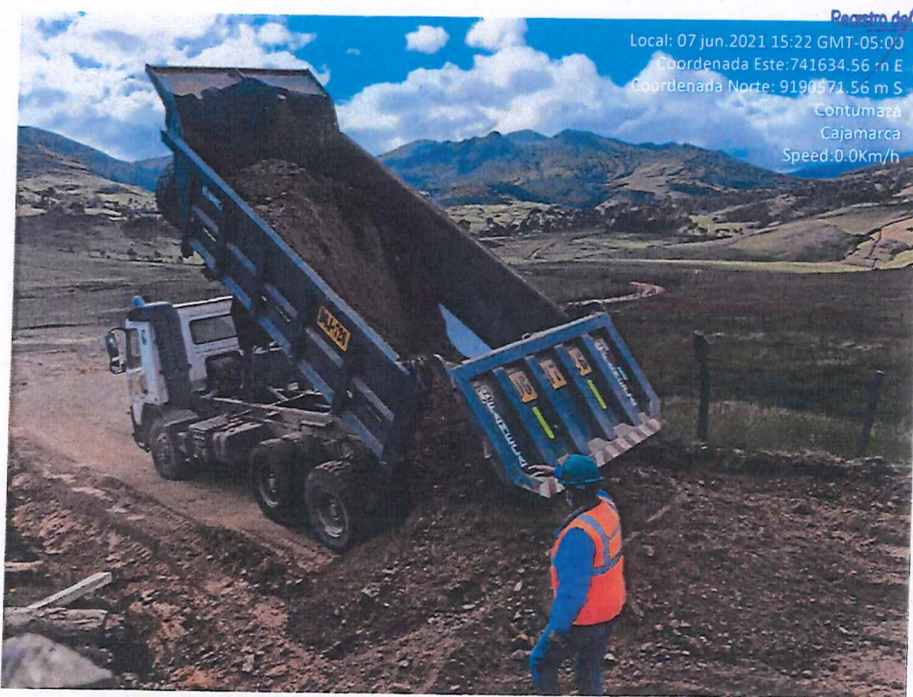
Fotografía 24. Descarga del material para el afirmado.
