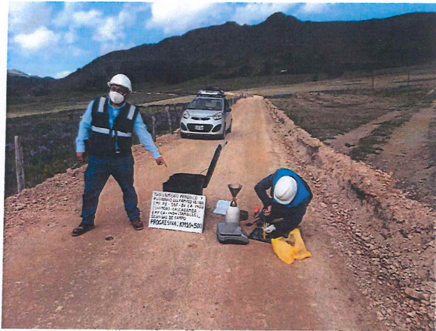
FIGURA N° 43. Ensayo de Densidad de Suelo en Campo. Progresiva 10 + 500 (Método del cono de arena).
