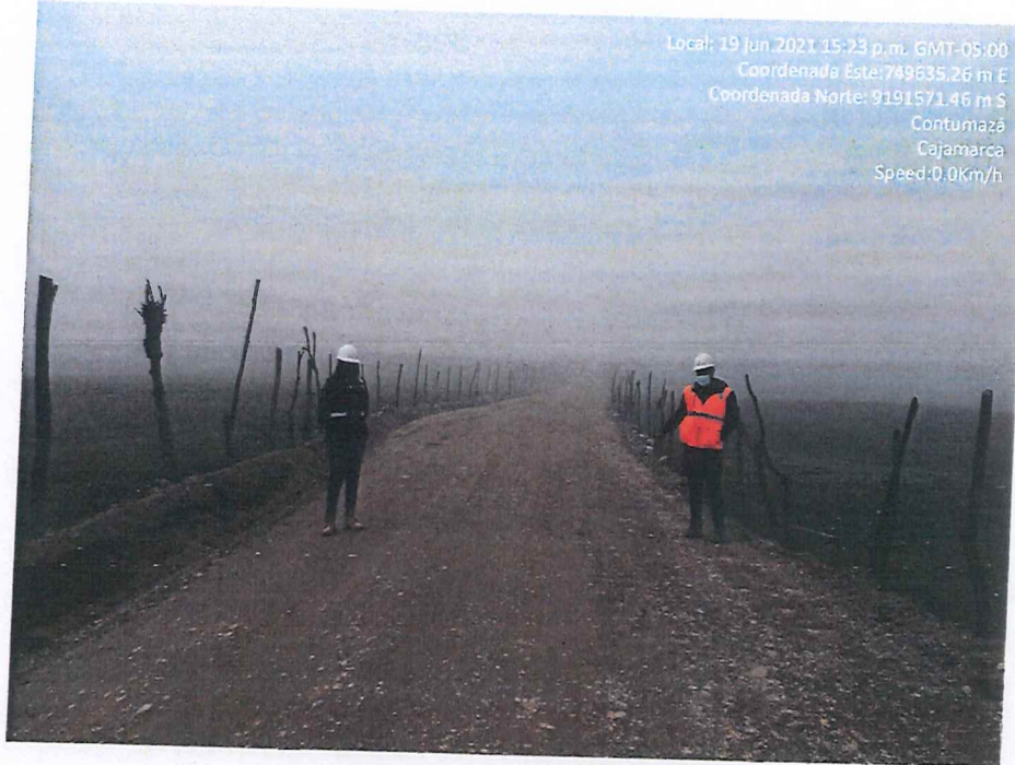
Fotografía 51. Resultado de la compactación del afirmado y verificación de los trabajos en campo por parte de la Entidad.
