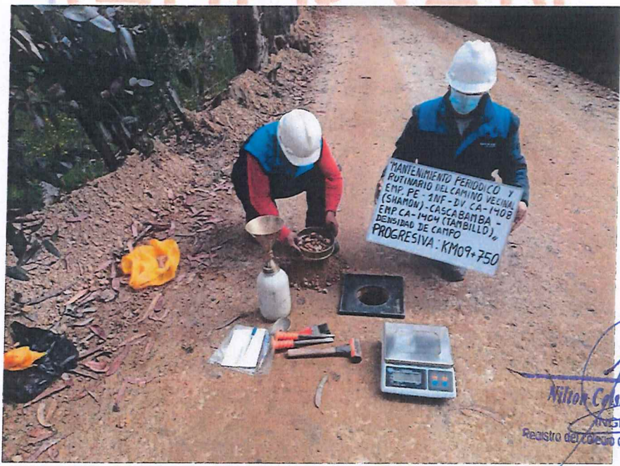
FIGURA N° 40. Ensayo de Densidad de Suelo en Campo. Progresiva 09 + 750 (Método del cono de arena).
