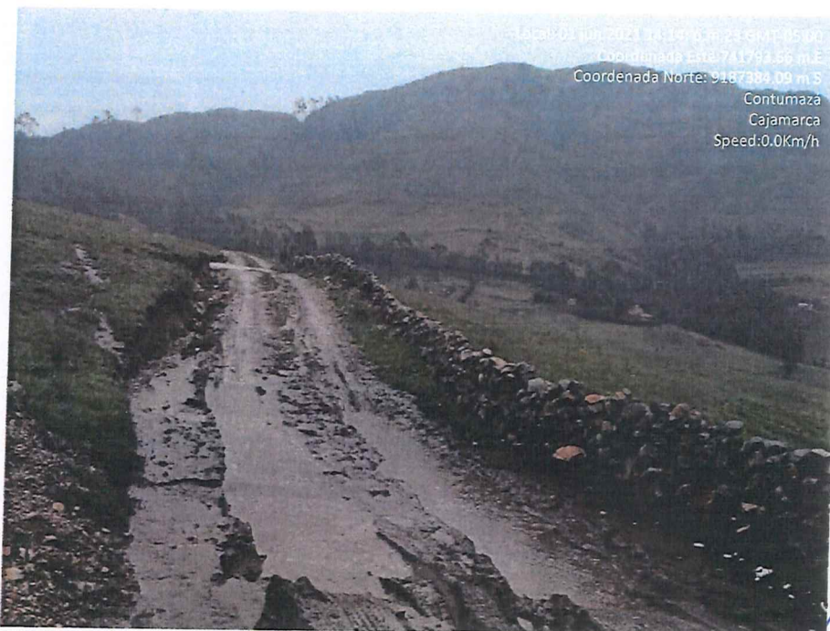
Fotografía 3. Estado del tramo antes de la suspensión de la Fase II.
