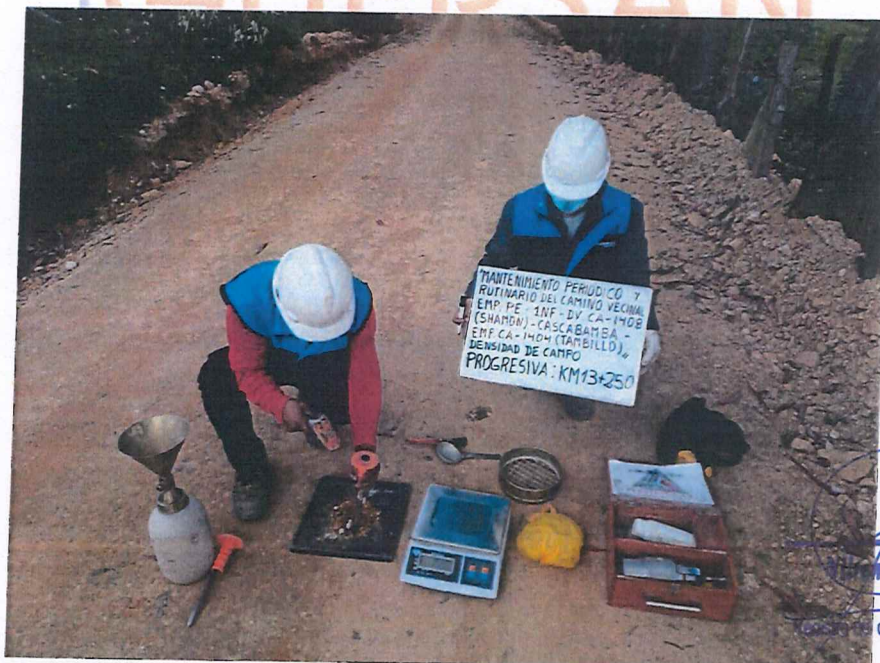
FIGURA N° 54. Ensayo de Densidad de Suelo en Campo. Progresiva 13 + 250 (Método del cono de arena).
